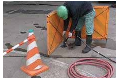
図2 営業中給油所での微生物注入
