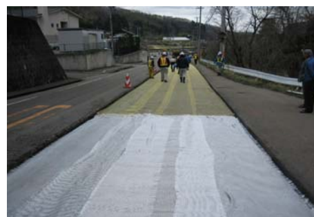
図1 ジオテキスタイルの試験施工現場
