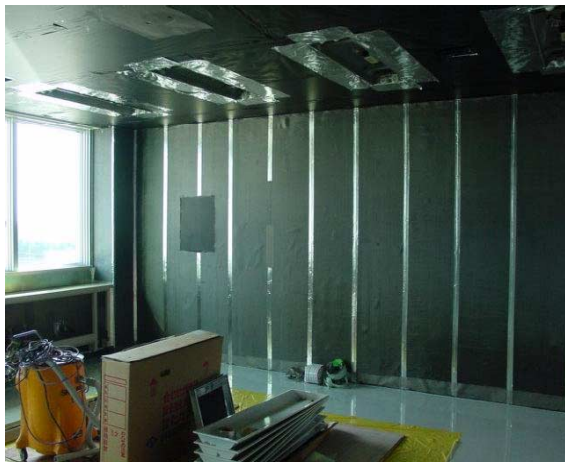
図1 電磁波シールドオフィスモデルルーム(左写真:工事中,右写真:完成後外景)
