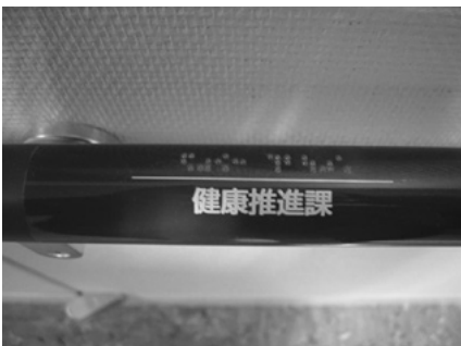
図8 手すりに設置した室名表示の点字案内板
