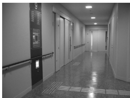
図1 誘導用ブロックと手すりによる誘導
