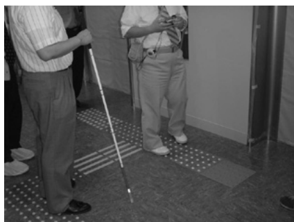
図2 誘導用ブロックの敷設方法の検討
